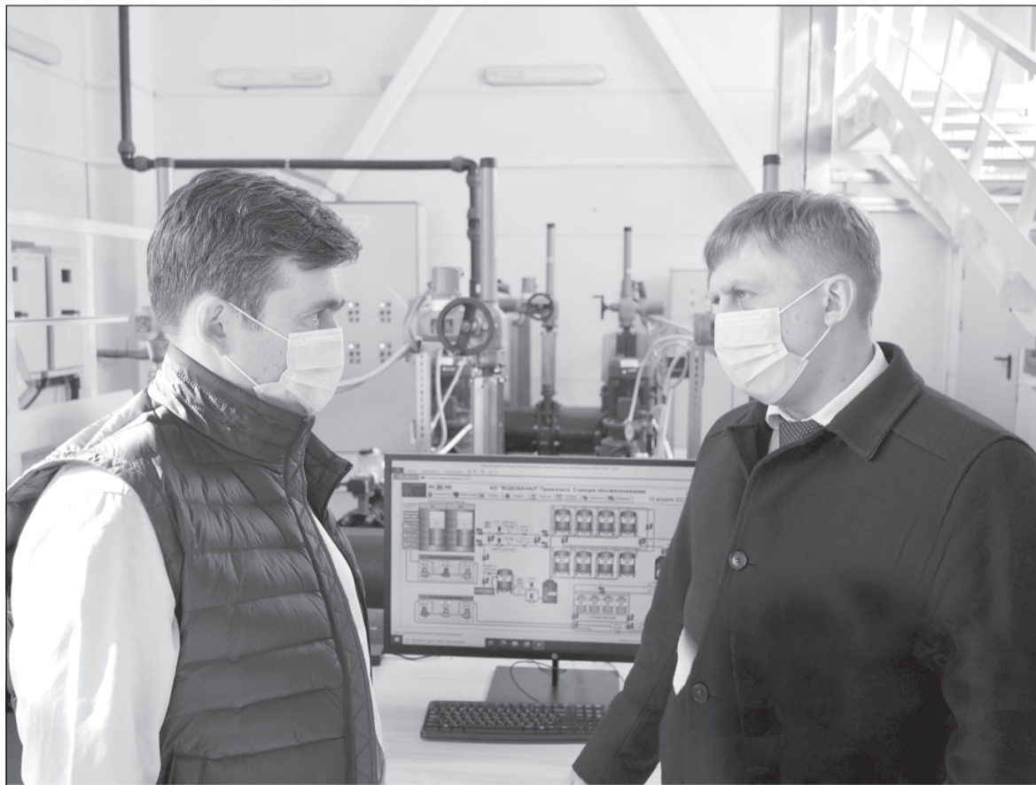
Губернатор Ивановской области Станислав Воскресенский во время рабочей поездки в Приволжский район посетил станцию обезжелезивания. Фото Д. Рыжакова
